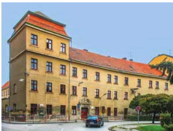
Západná fasáda Adalbertina orientovaná do Ulice Jána Hollého, súčasný stav
