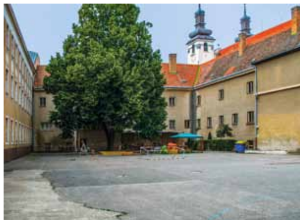
Nádvorie, pohľad od východu, súčasný stav
