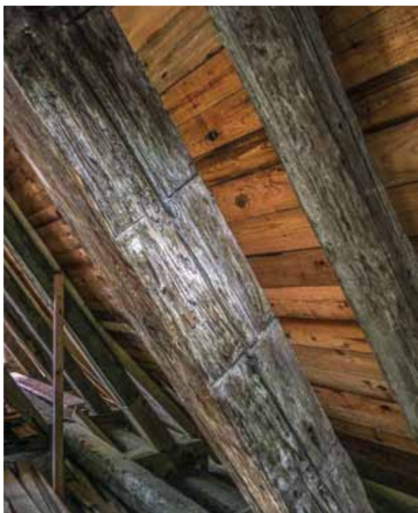
Krovová konštrukcia nad kaplnkou
