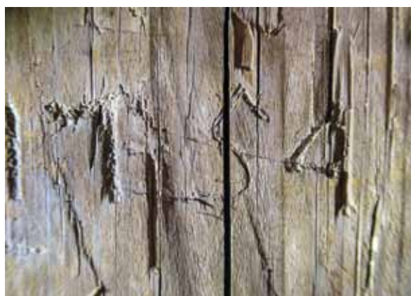
Rok 1754, predpokladané datovanie vzniku jestvujúceho krovu
