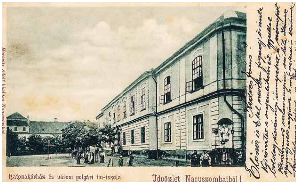
Budova bývalej lekárskej fakulty a Adalbertina na historickej pohľadnici, začiatok 20. storočia
