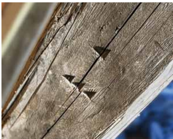
Montážne tesárske značenie a protiznačka v podobe trojuholníkových zásekov
