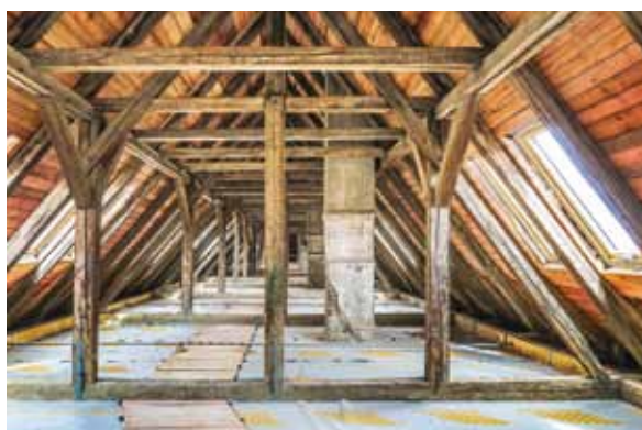
Podkrovia nad severným krídlom, pohľad zo západu na východ
