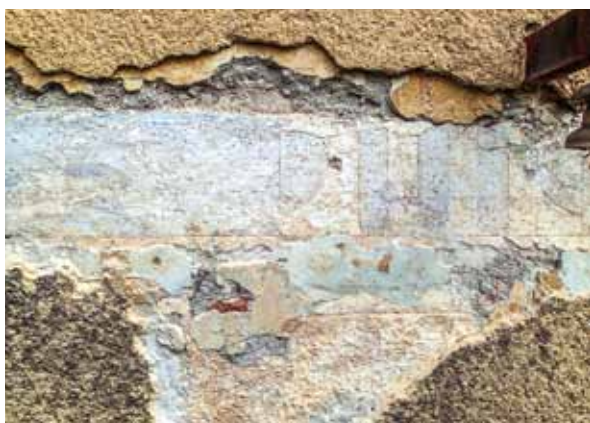
Objav maľovanej výzdoby korunnej rímsy na dome susediacom od juhu s prvým Adalbertinom, polovica 17. storočia
