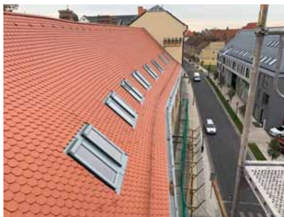
Obnovená strecha nad západným krídlom, 2019
