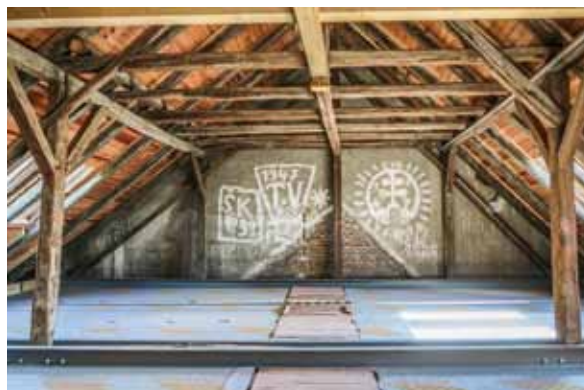
Podkrovia nad západným krídlom, pohľad so severu na juh
