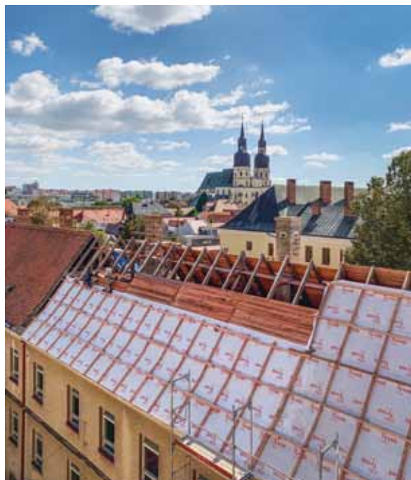
Realizácia obnovy, pohľad z nárožného objektu „vežice“ na juhovýchodnú stranu, 2019
