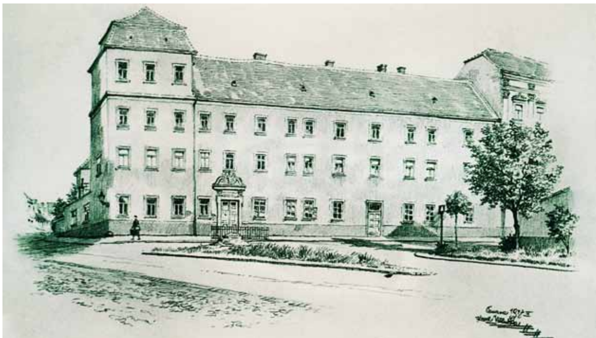
Adalbertinum po nadstavbe druhého poschodia, kresba Karla Votlučku z roku 1947
