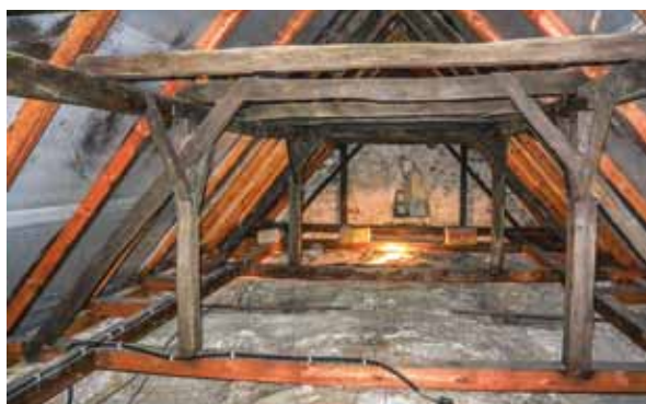
Krov nad loďou Kostola Panny Márie v Trstíne-Hájičku, pohľad z východu na západ
