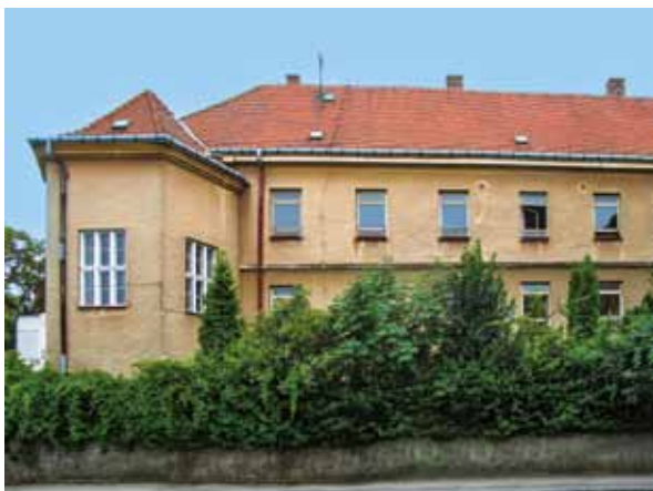
Východná polovica severnej fasády s predstupujúcim trojbo- kým ukončením kaplnky, súčasný stav
