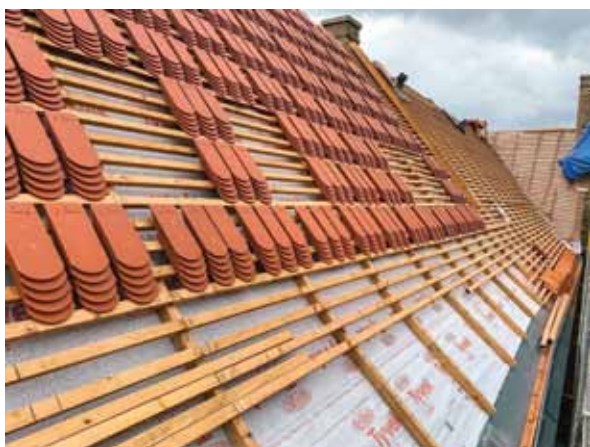
Strecha nad severným krídlom počas obnovy, 2019
