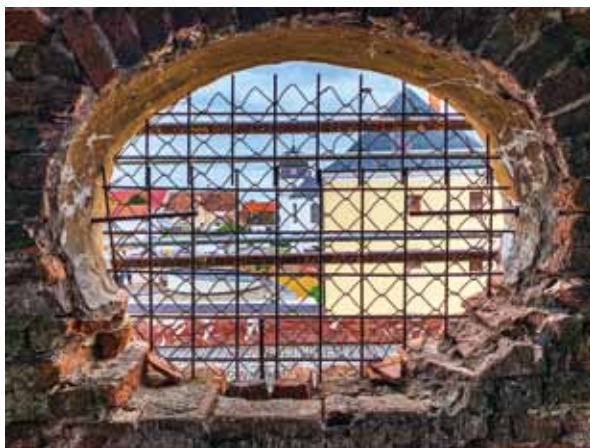
Okno v tvare elipsy v štíte kaplnky – pohľad z podkrovia na budovu seminára Rubrorum
