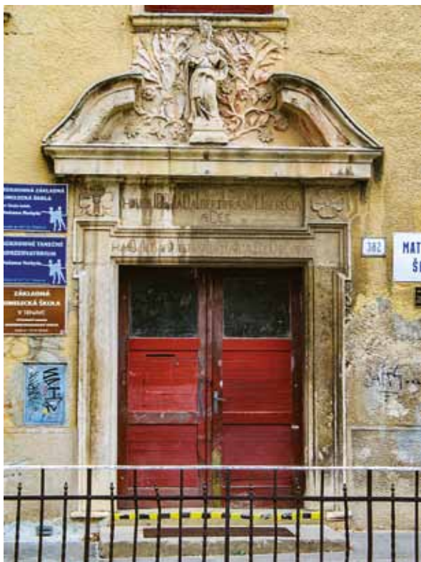
Vstupný portál v západnej fasáde Adalbertina, súčasný stav Foto: Jaroslava Žuffová
