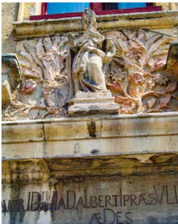
Vstupný portál v západnej fasáde Adalbertina - detail nadpražia so sochou sv. Vojtecha a štukovou rastlinnou dekoráciou, súčasný stav Foto: Jaroslava Žuffová
