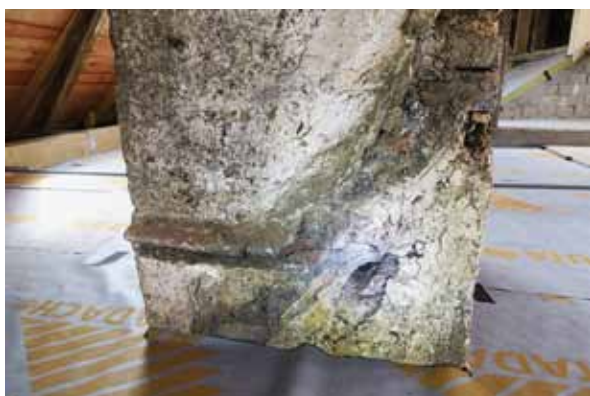
Odilačok pláštia strechy objektu pred nadstavaním 3. nadzemného podlažia so stopou šindľovej krytiny spolu s kapsami dvoch radov strešných lát
