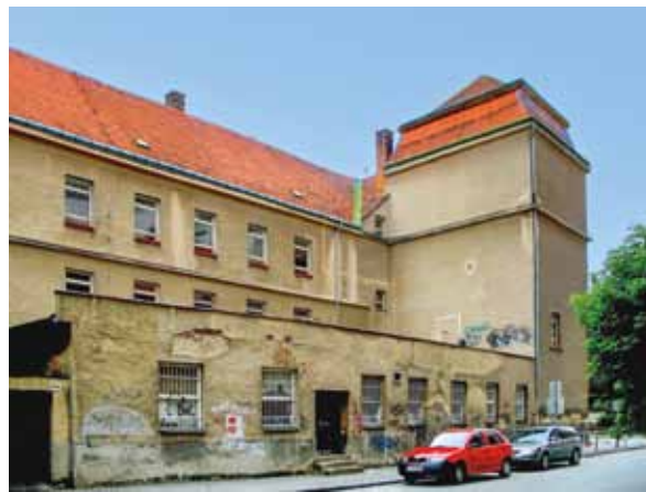
Západná polovica severnej fasády orientovanej do Invalidskej ulice, súčasný stav
