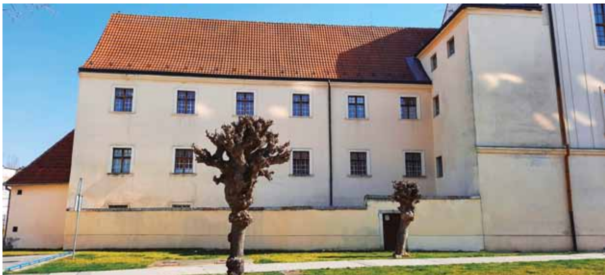
Budova bývalej tlačiarne, uličná fasáda, 2023
