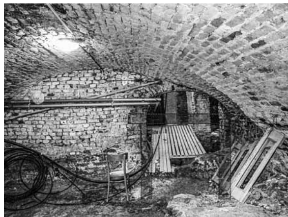
Pohľad od západu do interiéru pivnice prvého stredovekého murovaného domu na parcele budúceho Adalbertina, súčasť stav s mladšou klenbou
