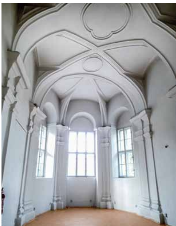
Interiér kaplnky so zaklenutím valenou klenbou s podkasanými styčnými výsečami, pohľad od juhu, súčasný stav
