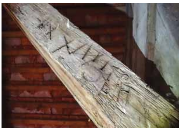
Prevrstvenie viacerých systémov montážneho tesárskeho značenia pochádzajúcich z rôznych etáp opráv
