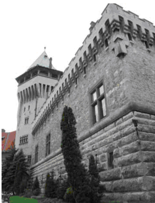
Obr. 5 Fasáda Smolenického zámku z dobrovodského kameňa opracovaného rôznymi kamenárskymi spôsobmi. (Foto: Hornáčková 2009)
