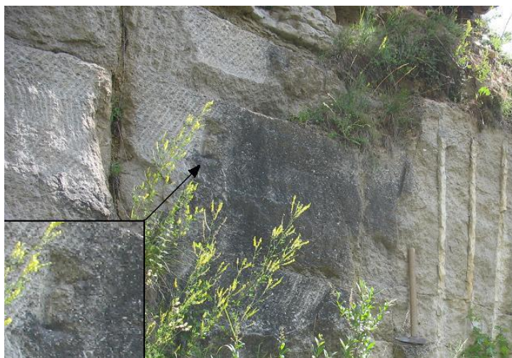
Obr.4 Stopy po šicaku, kamenárska značka a stopy po novodobej ťažbe v lome Kostolná Hôrka. (Foto: Hornáčková 2009)
